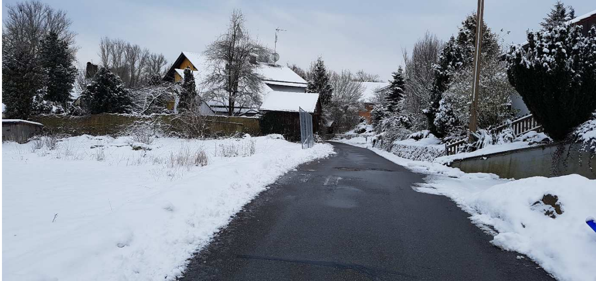
Blick von Norden auf den Postweg mit bestehender Siedlungsbebauung; links: Planungsfläche
